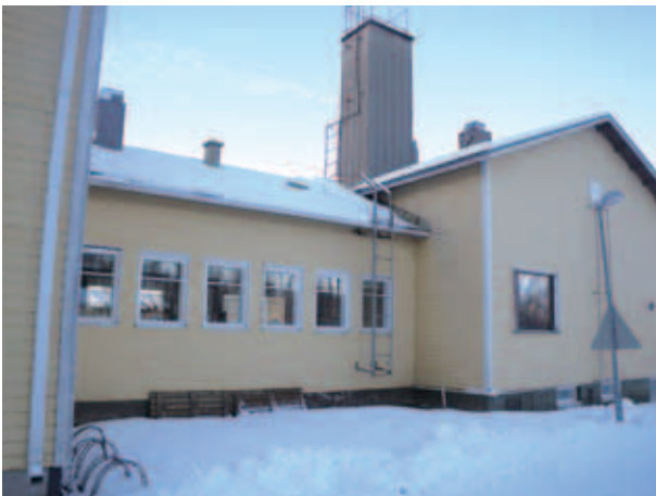
写真4 幼稚園及び食事室等がある棟
