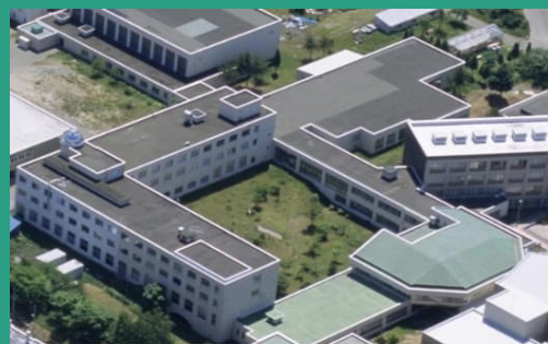
岩見沢校中央棟（昭和54年築） 鉄骨造3階建 延べ床面積7,014㎡ 【概要】岩見沢校中央棟は各建物を繋ぐ役割があり、多くの学生が利用します。
