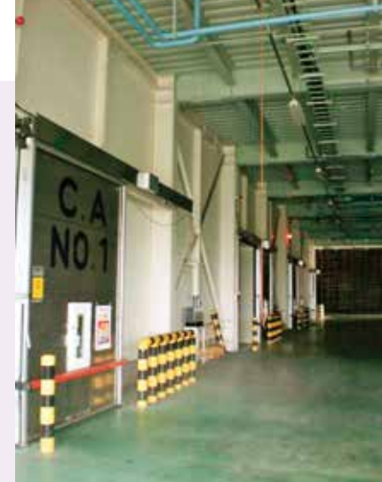
集出荷業者の保有するCA貯蔵庫(内部)
