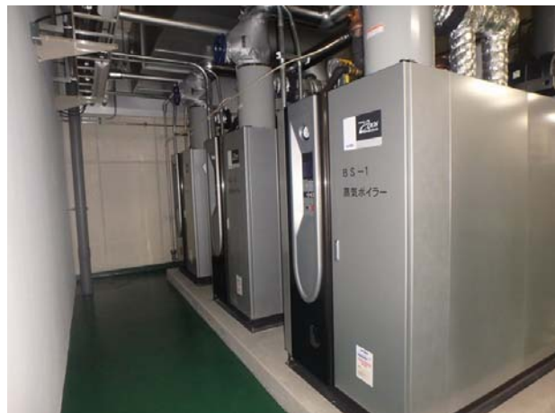
函館校暖房設備更新工事（更新後）
