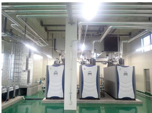
旭川校暖房設備更新工事（更新後）
