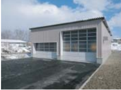
■函館校車庫新営工事
