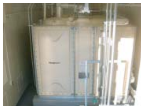
■釧路校学生寄宿舎受水槽新設工事
