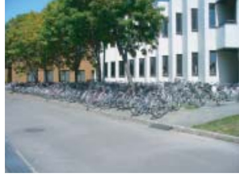
■札幌校駐輪場新設工事
