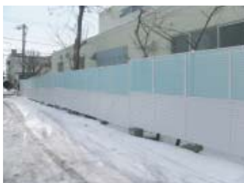
■函館校女子学生寄宿舎困障改修工事
