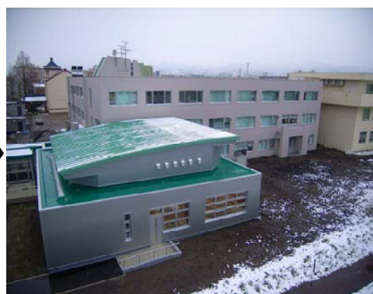
函館校7号館校舎外観（改修後）
