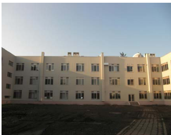
旭川校自然科学棟外観（改修後）
