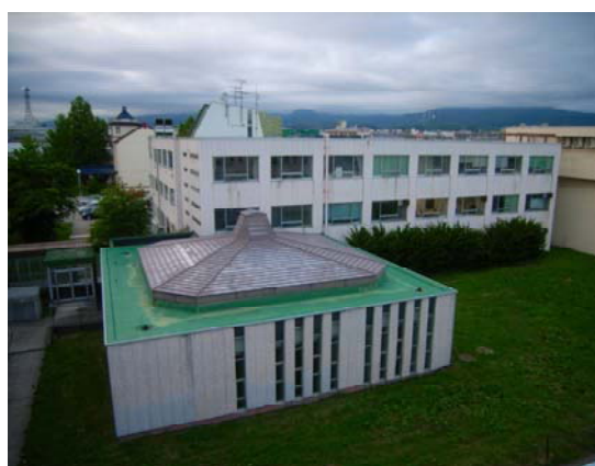
函館校7号館校舎外観（改修前）
