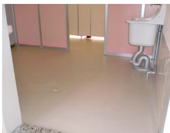
附属釧路中学校生徒トイレ床等修繕工事（改修後）
